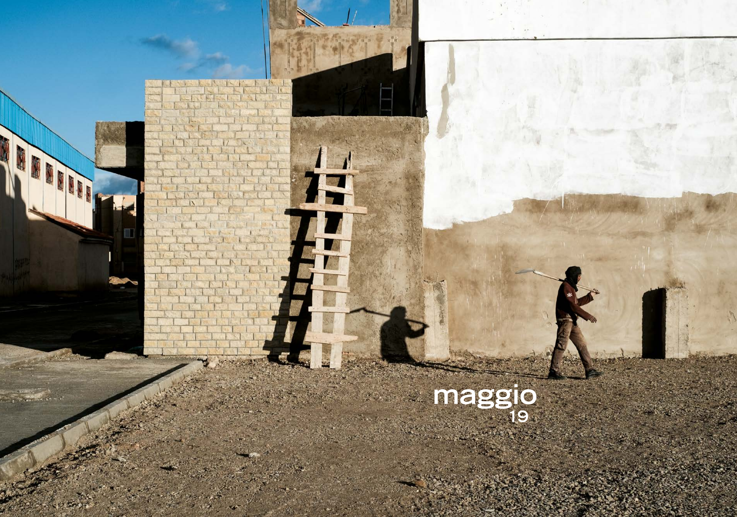
Un uomo con la pala al lavoro in un cantiere della città di Midelt. Marocco Foto di Simone Giovanni Colombo
